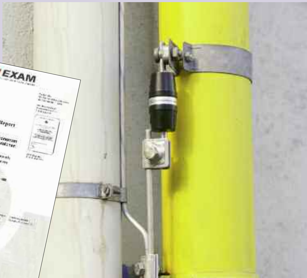
Fig.: Ejemplo de aplicación de la vía de chispas de separación tipo 481
