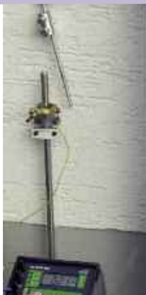
Medición de la resistencia de tierra
