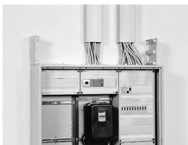
Fijación de las tapas finales encajándolas en las pestañas
