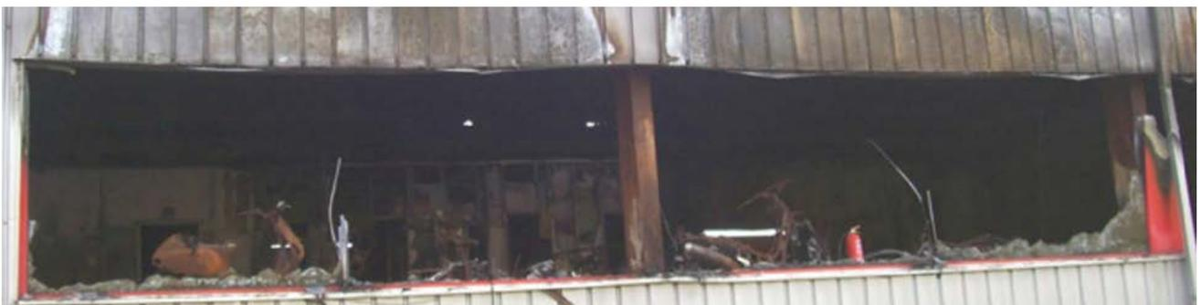
Brandschaden durch korrosive Gase
