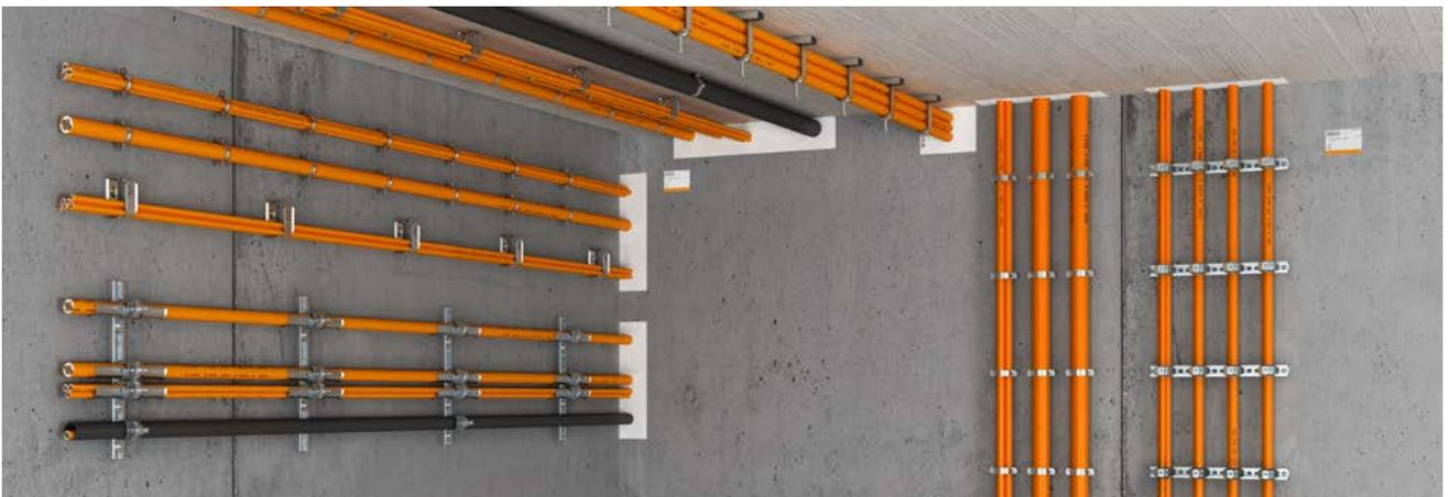
Bei der Auswahl der für den Funktionserhalt zugelassenen Produkte sind die Vorgaben des Planers und die Angaben der Prüfzeugnisse zu beachten. Alle Parameter zur Montage und zu den verwendbaren Bauteilen müssen den Prüfzeugnissen entnommen werden. Es muss sehr stark auf die zulässige Kombination mit geprüften Kabeln geachtet werden.
